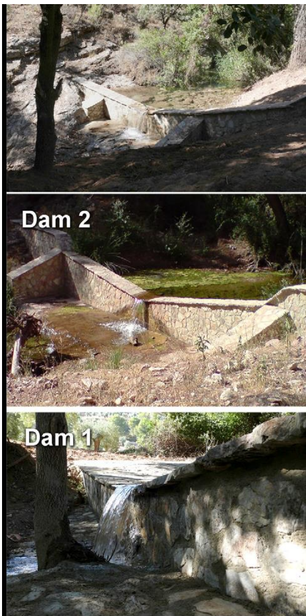
Obr. 34. Návrh jezu zabraňující šíření raka červeného (Dana et al. 2011)
