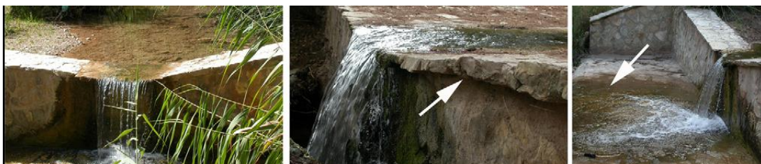
Obr. 35. Návrh koruny jezu zabraňujícího překonání překážky invazním rakem červeným (Dana et al. 2011)
